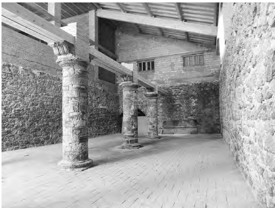
Fig. 4. Estado actual del alfolí (Foto: Ánchel Conte)
