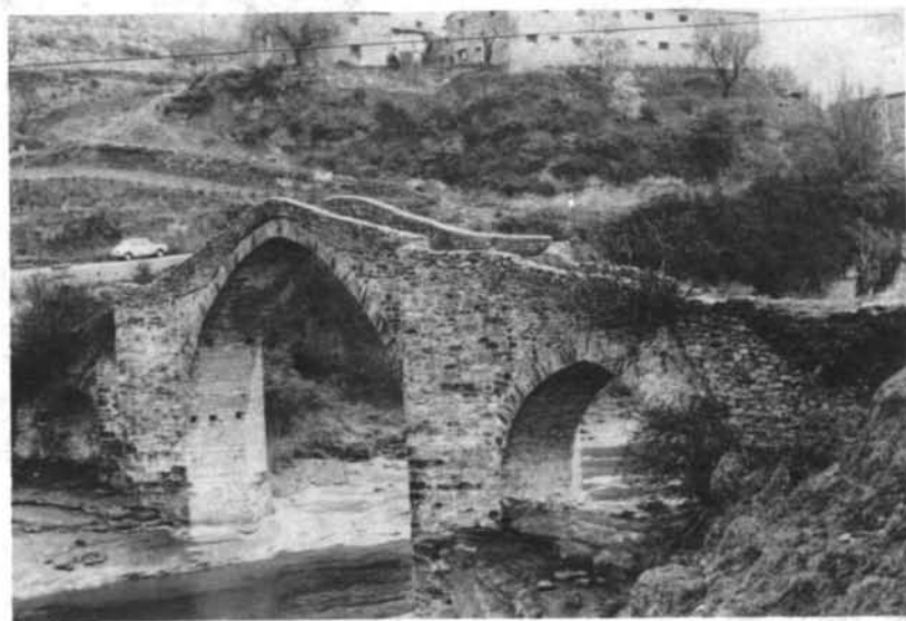
Lám. II. PUENTE DE SANTA LIESTRA Y SAN QUILEZ. Sobre el río Esera, no aparece mencionado en la documentación, pero sus rasgos estructurales son elocuentes: perfil en cuesta pronunciada, calzada estrecha, tajamares de sección triangular y marcados en planta configurando apartaderos.
