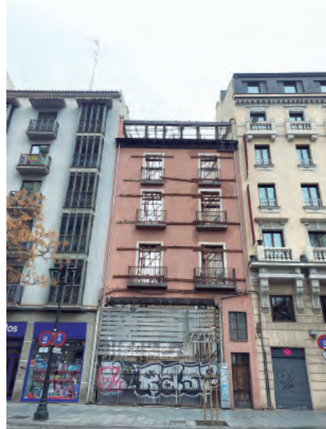
Fig. 4. Estado actual del edificio de la calle del Coso, n.º 9. Fotografía: autor, enero de 2024.
