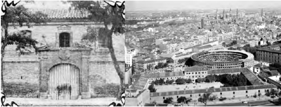
Fig. 4. Vista de la portada de la fachada occidental o posterior del Cuartel de Caballería de Zaragoza en 1908, en el centenario del primer asedio francés de la ciudad (izquierda). Vista panorámica del mismo cuartel, que se observa en primer plano, en octubre de 1963, poco antes de ser desmilitarizado (derecha). Fotografía: Trabajos Aéreos y Fotogramétricos.
