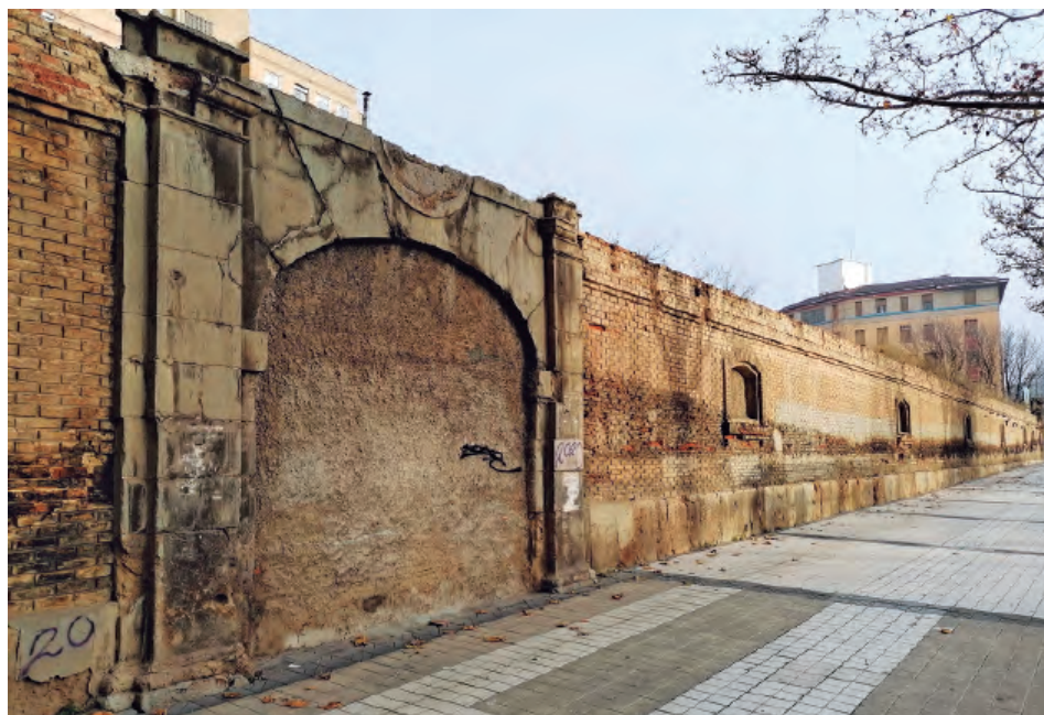
Fig. 1. Vista general del viejo muro occidental del Cuartel de Caballería, incluida su portada, a finales de diciembre de 2020, poco antes de que se decidiera su preservación parcial.
