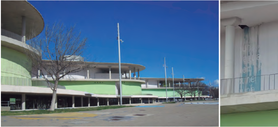
Fig. 5. Vista general y detalle de los edificios Ebro 3, 4 y 5 [I. Y.].
