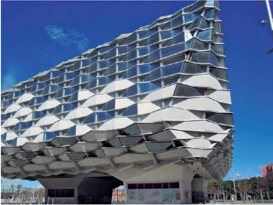
Fig. 9. Vista del Pabellón de Aragón desde el andador Abogacía Turno de Oficio [I. Y.].
