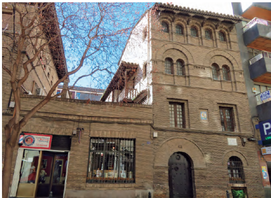
Fig. 4. Fachada de la Casa Moneva en el número 12 de la calle Sanclemente, en Zaragoza (2024).
