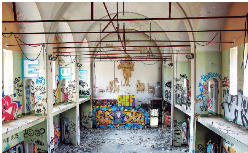
Fig. 6. Grafitis en el interior de la capilla del Centro de Reforma (o Residencia) San Jorge, antiguo reformatorio o casa tutelar El Buen Pastor, ubicado en el barrio de Valdefierro de la ciudad de Zaragoza (derruido en 2022). Fotografía: Juan Carlos Lozano.
