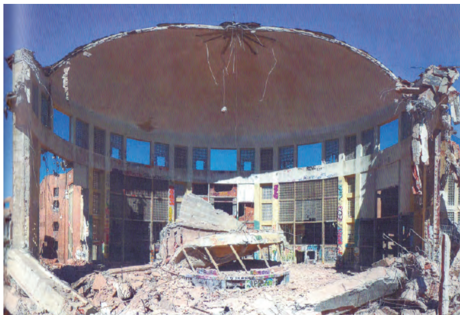
Fig. 3. Demolición de la prisión de Carabanchel en octubre de 2008. Fuente: Carabanchel. El derribo de la vergüenza, monografía de Jesús Rodríguez, 2015.
