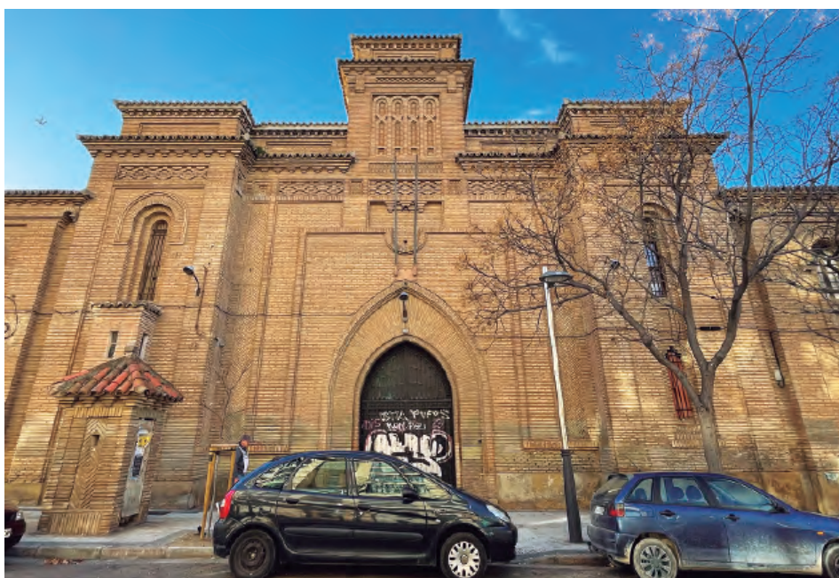
Fig. 5. Detalle de la fachada principal de la antigua prisión provincial de Torrero, Zaragoza, 2024. Fotografía: autora.
