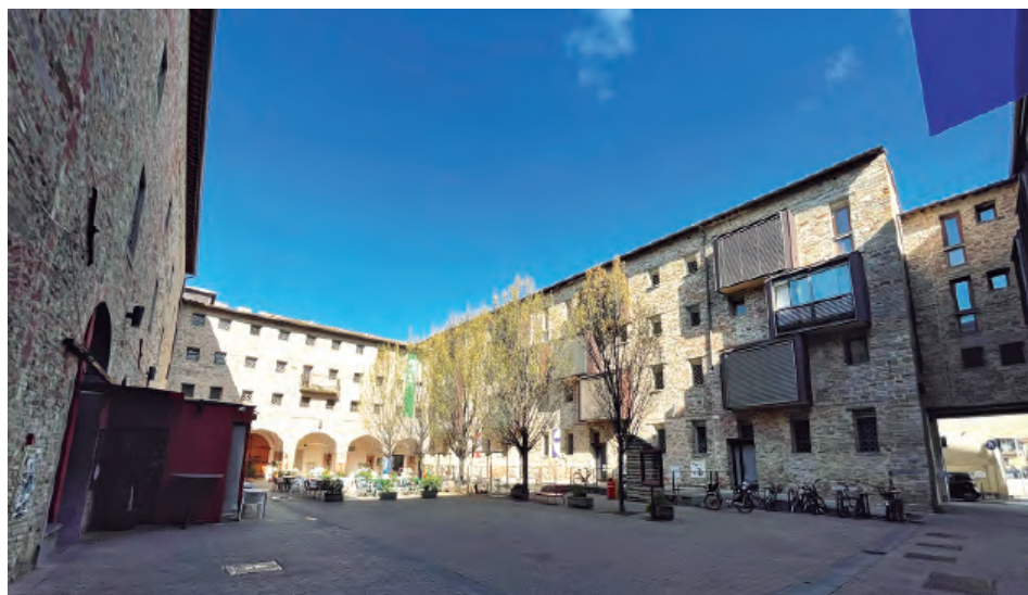
Fig. 14. Le Murate, Florencia. Vista general de la Piazza delle Murate creada en el complejo carcelario, en la que se observan las galerías transformadas en viviendas, 2023. Fotografía: autora.
