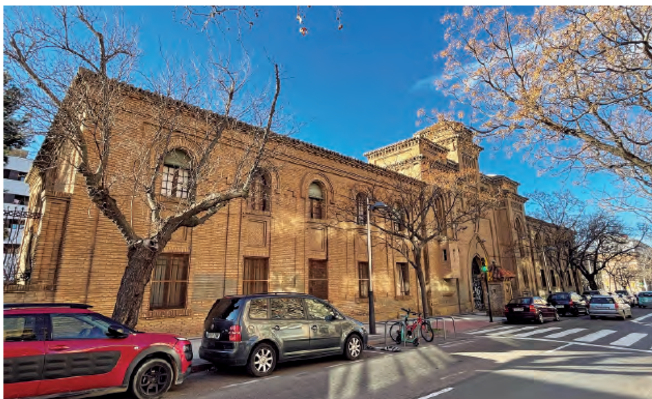
Fig. 4. Fachada principal de la antigua prisión provincial de Torrero, Zaragoza, 2024. Fotografía: autora.
