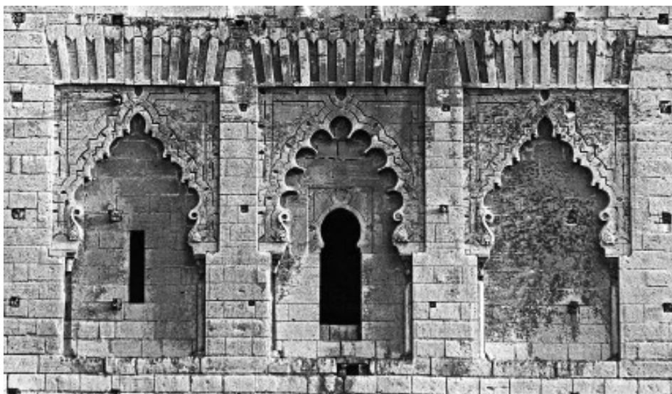
Fig. 2. Detalle de la cara noroeste del alminar de la Mezquita de Hassān en Rabat (Marruecos), antes de la restauración de 2020. Fotografía: Ewert.
