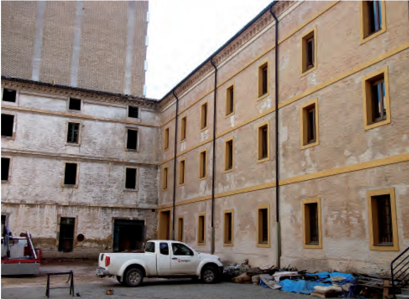
Fig. 15. Vista actual de las fachadas al patio de armas de las alas este (izquierda) y sur o frontal (derecha) del Cuartel de Convalecientes, construidas de nueva planta por Agustín Sanz. Tanto las líneas de imposta como el alero corresponden a una reforma del último cuarto del siglo XIX.
