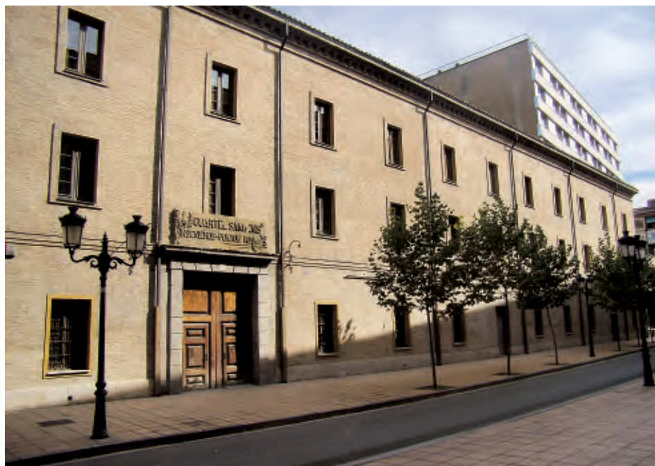
Fig. 1. Vista actual de la fachada principal del Cuartel de Convalecientes.
