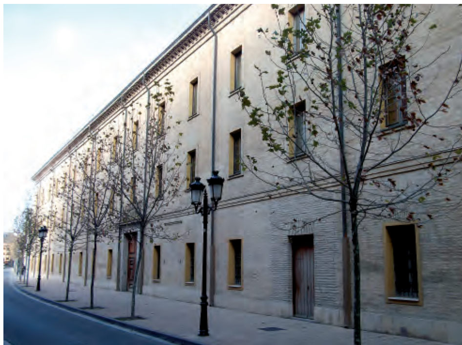
Fig. 14. Fachada principal del Cuartel de Convalecientes en la actualidad.
