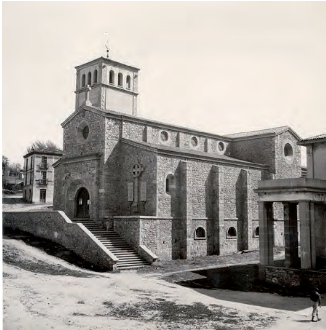
Fig. 6. Reconstrucción de la iglesia parroquial de Nava. Ministerio de Cultura (MCU). Archivo General de la Administración (AGA), Fondo Dirección General de Regiones Devastadas, caja F/04228, sobre 15.
