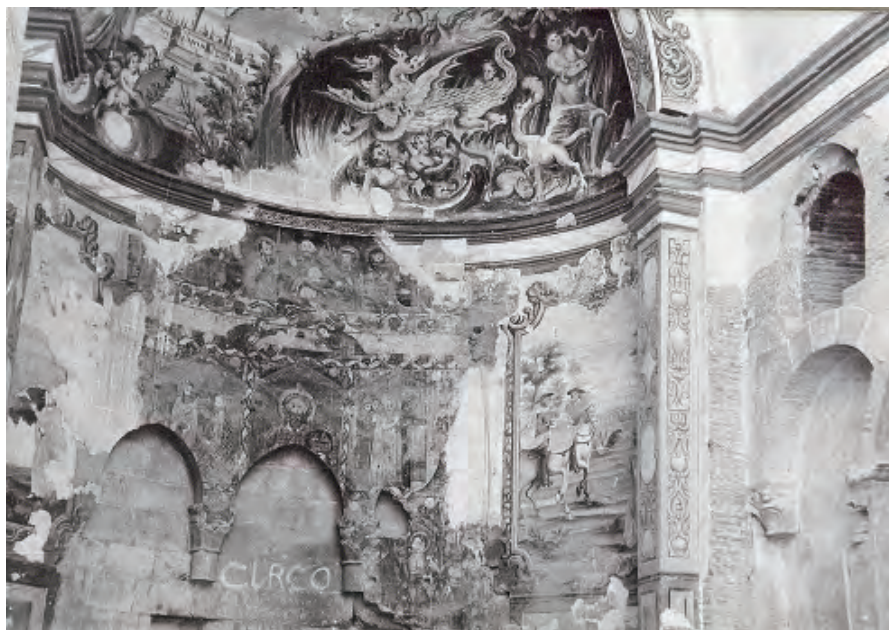
Fig. 8. Iglesia de San Juan. Detalle de las pinturas murales que decoraban el ábside antes de la restauración. 1967. Archivo de la empresa Tricás Comps.
