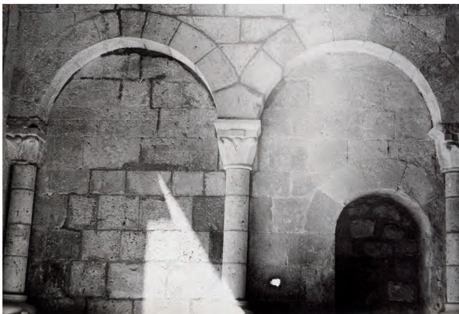
Fig. 14. Iglesia de San Juan. Las arcadas románicas del lateral del ábside (lado del Evangelio) completamente restauradas.1969. Archivo de la empresa Tricás Comps.
