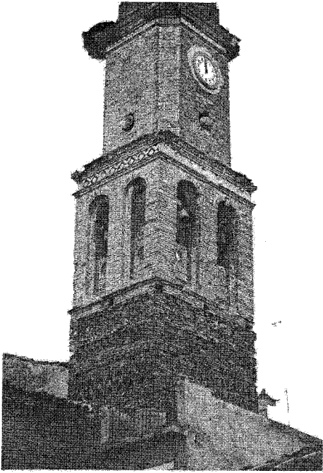
4. Torre de la iglesia del convento de San Salvador.
