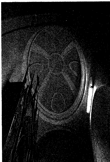
29. Detalle de la iglesia (cubierta de la capilla del segundo tramo de la nave).
