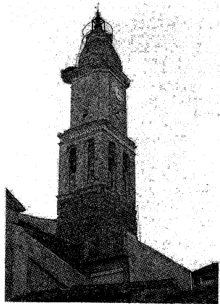
3. Torre de la iglesia del convento de San Salvador.
