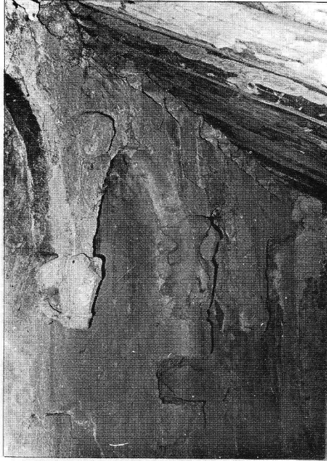
Fig. 5. San Fructuoso de Barós. Relieves en el exterior del muro sur de la nave, antes de la demolición de la sacristía adyacente.
