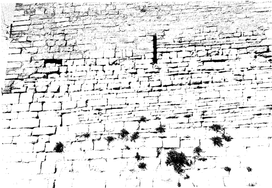
Fig. 9. Abizanda (Huesca). Torre del castillo del año mil, reconstruido por los maestros lombardos. Exterior, lado este: abajo, vestigios de la fortaleza prerrománica; arriba, reconstrucción lombarda.
