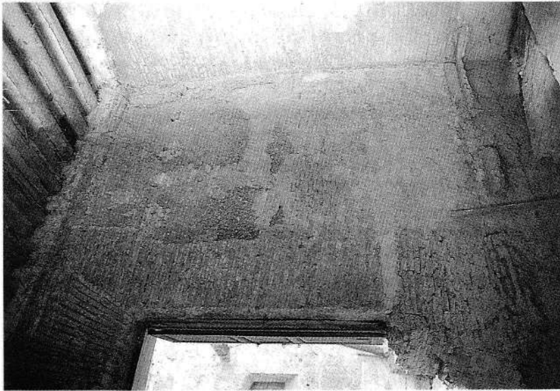
Fig. 2. Zaragoza. Palacio de la Aljofería. Alcoba oeste del Salón del Trono. Muro norte. Improntas del friso de ménsulas. Aspecto que presentaba en junio de 1994.
