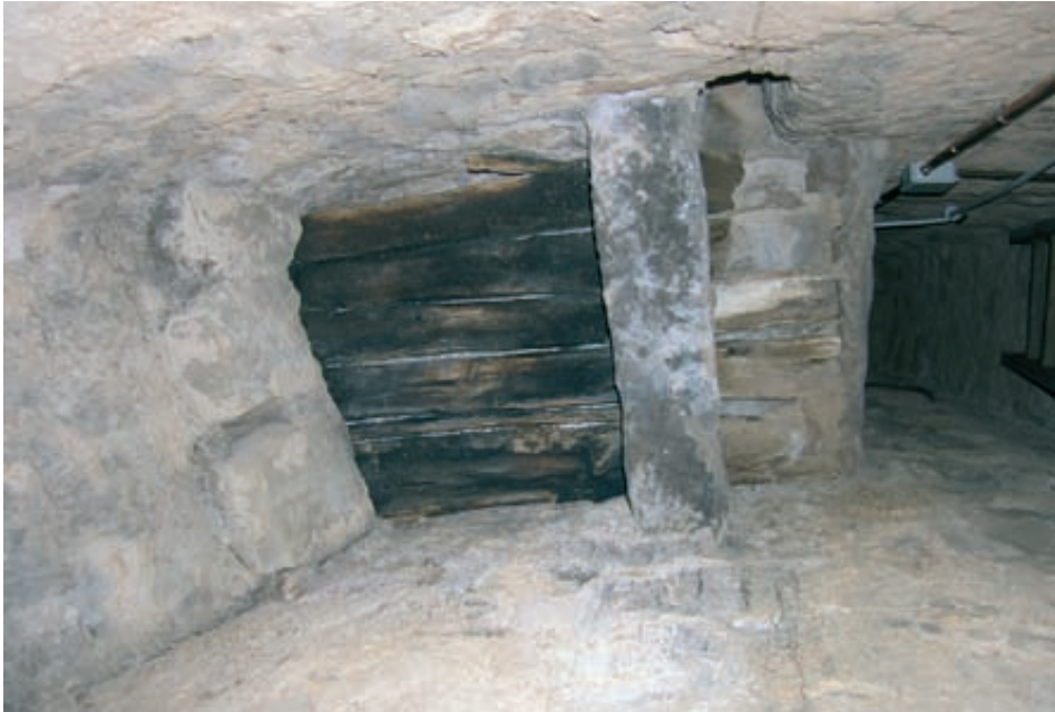
Fig. 18. Caja de escaleras. Suelo de madera del siglo X apoyado sobre grandes sillares de piedra y con un bordillo en su extremo superior externo correspondiente a la cota +18,85 metros visto desde abajo.
