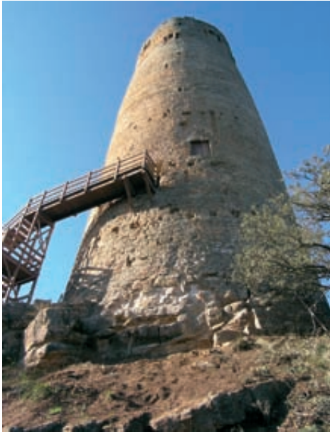
Fig. 5. Zona este con la puerta original consolidada y el acceso mediante escalera y pasarela al interior de la torre.
