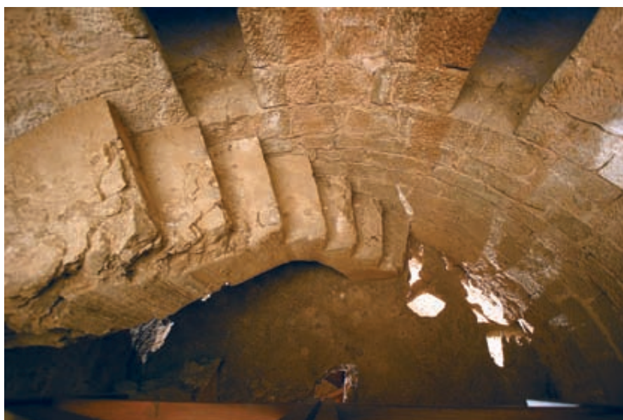
Fig. 13. Escalera pétrea existente en la zona suroeste que permite el acceso desde el nivel tercero hasta el nivel de los cadalsos inferiores.
