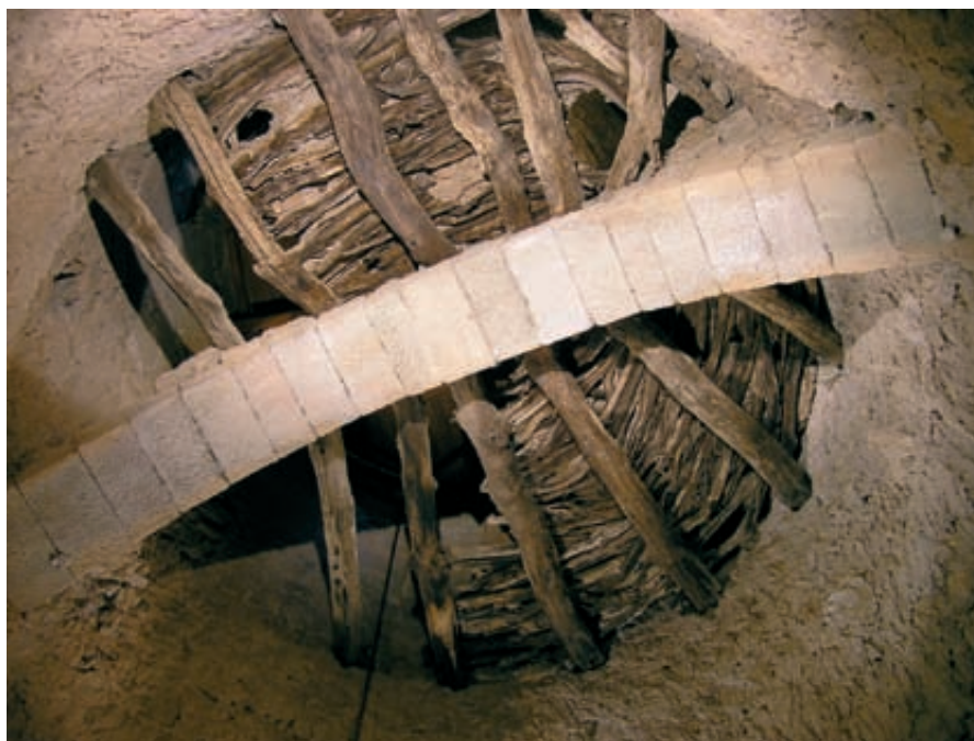
Fig. 12. Forjado original del tercer nivel apoyado sobre un arco diafragma construido hacia 1050.
