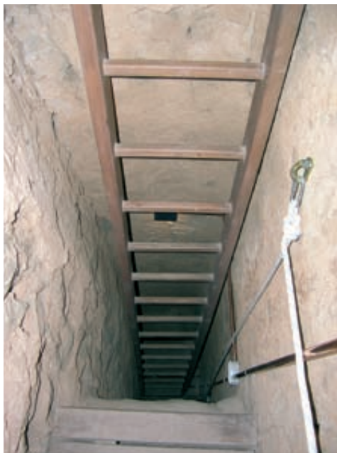
Fig. 19. Caja de escaleras. Suelo moderno superpuesto sobre el del siglo X de la cota +18.85 metros, para preservarlo, visto desde arriba.
