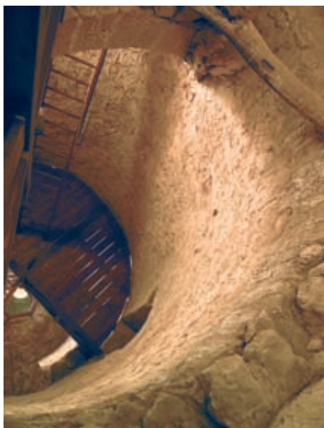
Fig. 11. En la derecha forjado de la mitad de la superficie de la planta del nivel de la letrina al que se accede por una escalera de madera y en la parte izquierda escalera de madera por la que se accede al forjado del nivel tercero que apoya sobre un arco diafragma construido hacia 1050.
