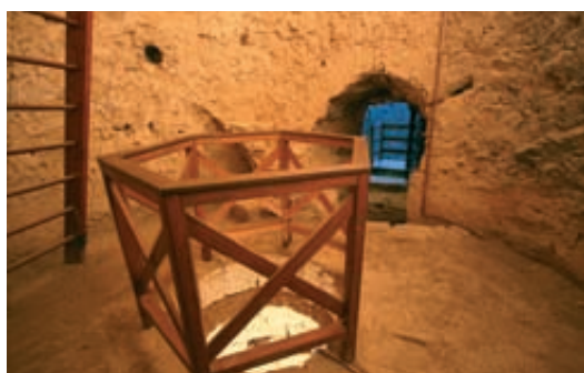
Fig. 8. Nivel de acceso con la puerta de la torre de la década de 1970, el óculo de la clave de la cúpula del almacén, el arranque de la escalera pétrea adosada a la pared y la escalera de madera mediante la que se accede al forjado del nivel de la letrina.
