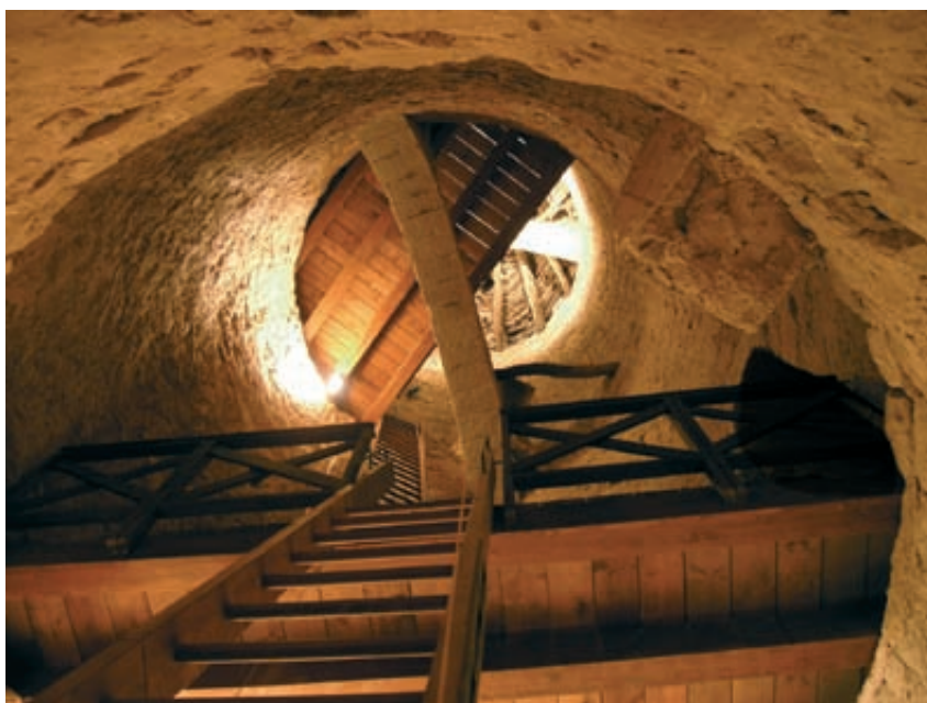
Fig. 10. Imagen en primer término de los dos forjados repuestos en la restauración sobre la mitad de la planta de cada nivel, y en el fondo forjado original del cuarto nivel.
