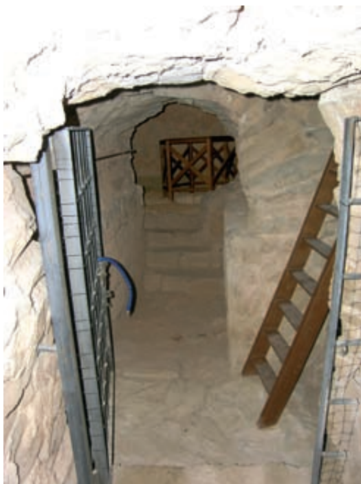
Fig. 7. Acceso habilitado en la restauración que aprovecha un hueco abierto en época moderna enfrente de la puerta de la primera fase, a la derecha la escalera por la que se accede a la puerta de la segunda fase.
