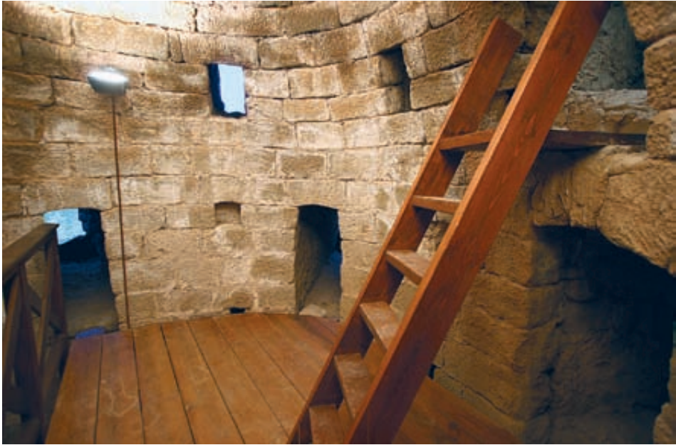
Fig. 15. Forjado de madera del nivel de cadalsos inferiores visto hacia el norte.
