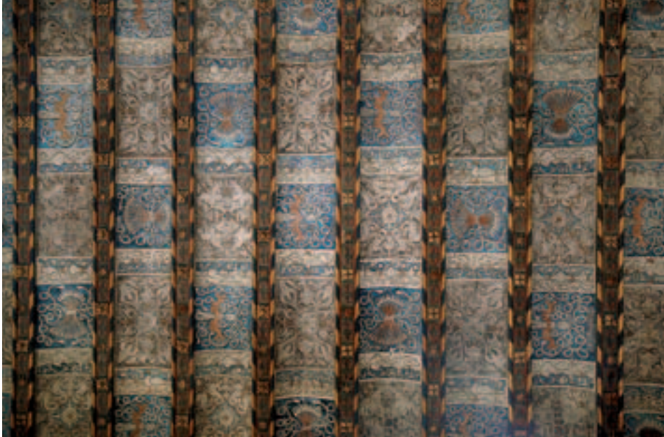
Fig. 15. Zaragoza. Palacio de la Aljafería. Escalera de aparato. Detalle del sistema de cubierta y de su decoración pictórica. Foto: Javier Ibáñez.
