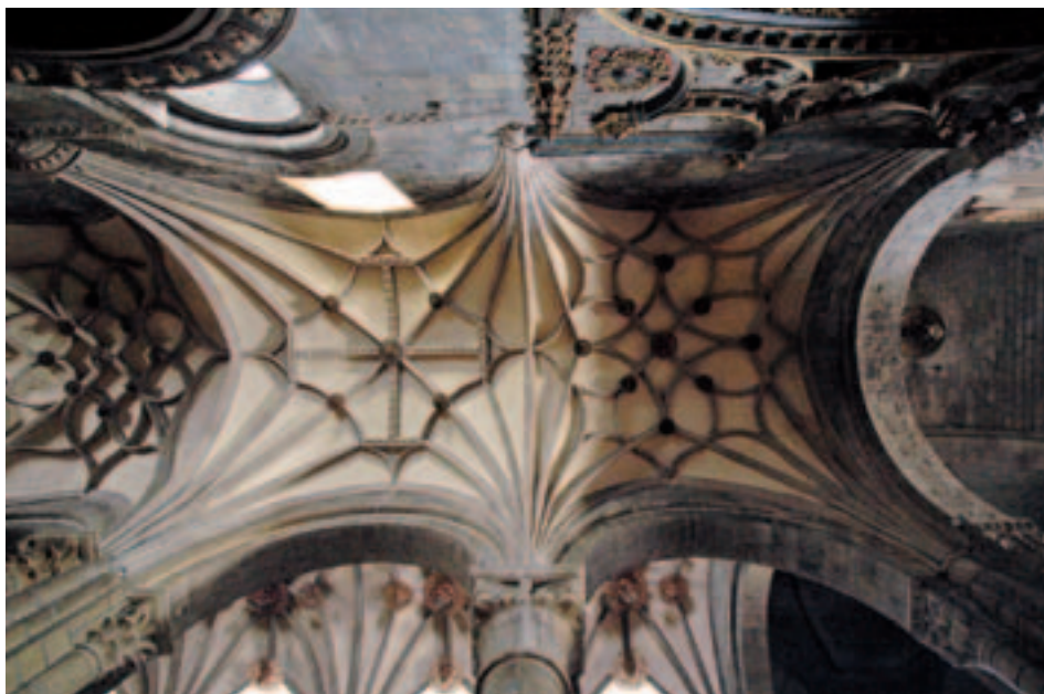
Fig. 11. Jaca (Huesca). Catedral. Detalle del sistema de abovedamiento aplicado en la nave de la Epístola. Foto: Javier Ibáñez.
