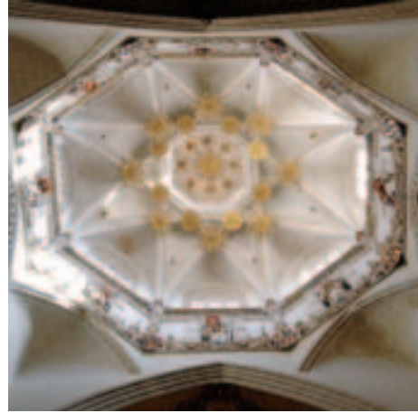
Fig. 7. Zaragoza. Catedral. Cimborrio. Interior. Foto: Javier Ibáñez.
