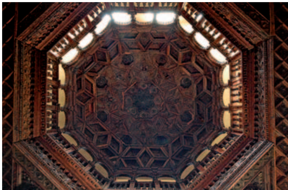
Fig. 30. Zaragoza. Palacio Donlope. Caja de escaleras. Detalle del sistema de cubierta. Foto: Javier Ibáñez.
