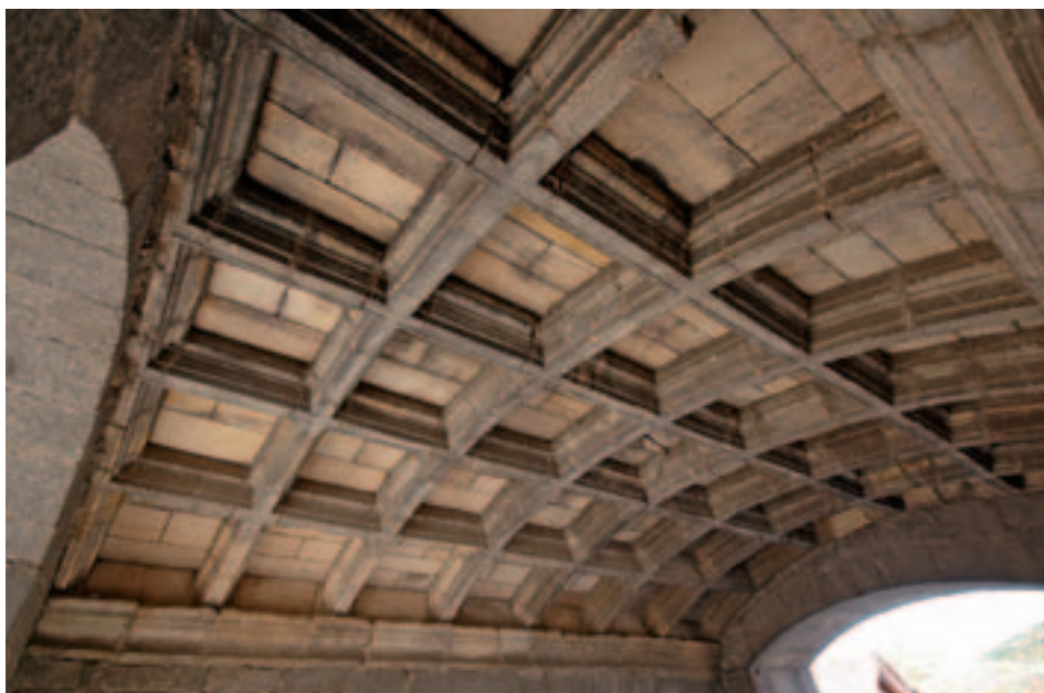
Fig. 35. Salvatierra de Escá (Zaragoza). Iglesia parroquial. Sacristía. Bóveda apainelada de crucería acasetonada. Foto: Javier Ibáñez.
