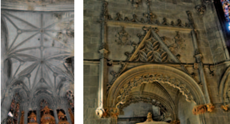
Figs. 29 y 30. Antoni de Bell-lloc. Capillas del arzobispo Cardona en la catedral de Tarragona. Bóvedas y detalle del alzado de la capilla de la Anunciación (ca. segundo cuarto del siglo XVI).
