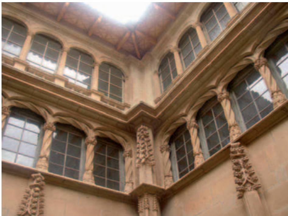
Fig. 25. Joan Llopis. Claustro principal del convento de franciscanos de Bellpuig de Urgel. Detalle de las galerías superiores (1533-1535, la galería gótica; siglo XVII, la del segundo piso).
