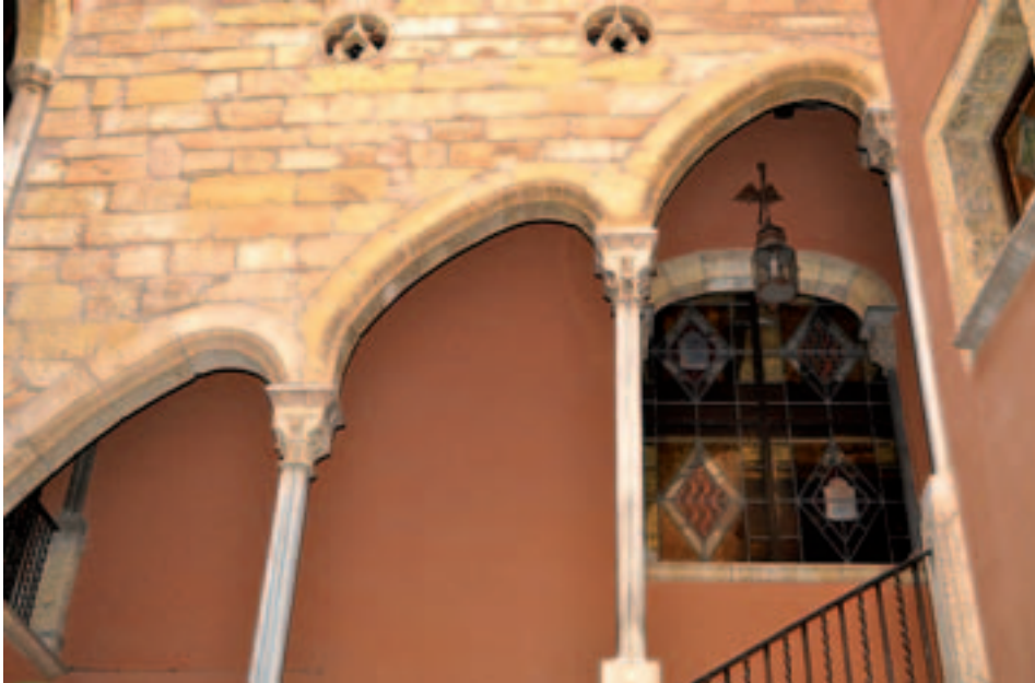
Fig. 9. Patio de la casa Castellarnau de Tarragona. Arcos rampantes de la escalera principal (inicios del siglo XVI).
