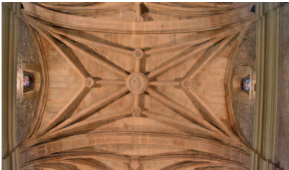
Fig. 5. Iglesia parroquial de La Pobla de Massaluca, bendecida en 1608. Detalle de las bóvedas de la nave.
