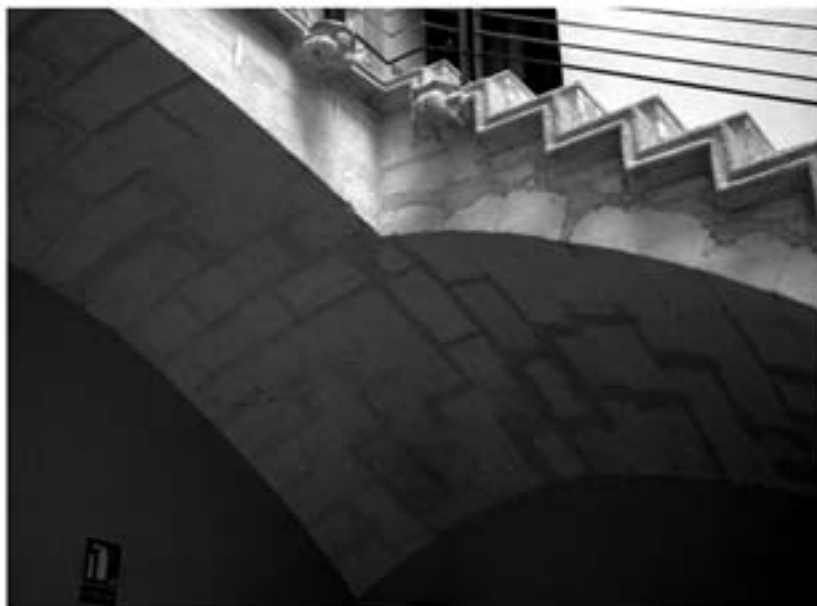
Fig. 10. Escalera de bóvedas del antiguo palacio de los Sancho de Onteniente (Valencia). Fotografía antigua y restauración reciente.
