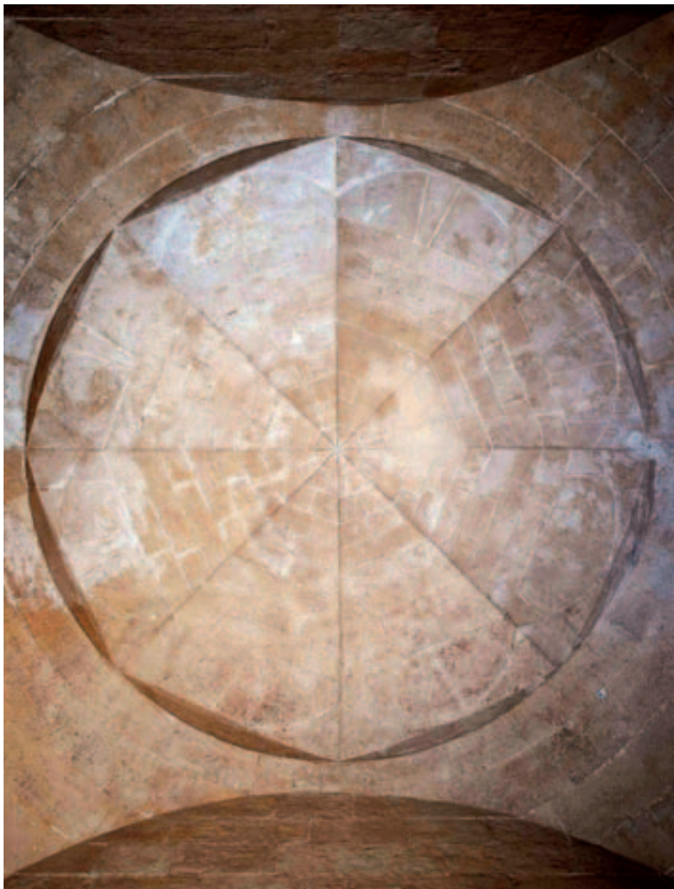
Fig. 7. Lonja de Valencia. Bóveda de la cárcel de comerciantes.
