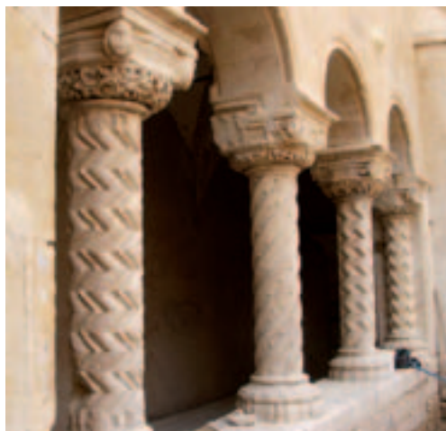
Fig. 5. Modica. Complesso di S. Maria di Gesù. Chiostro, particolare dei sostegni del primo ordine del loggiato.
