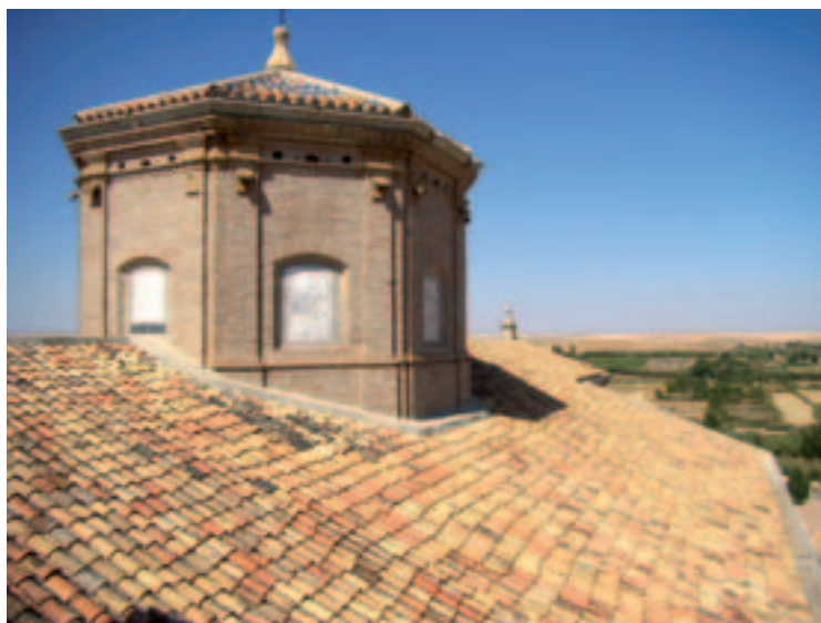
Fig. 15. Cúpula central sobre el crucero desde el exterior.
