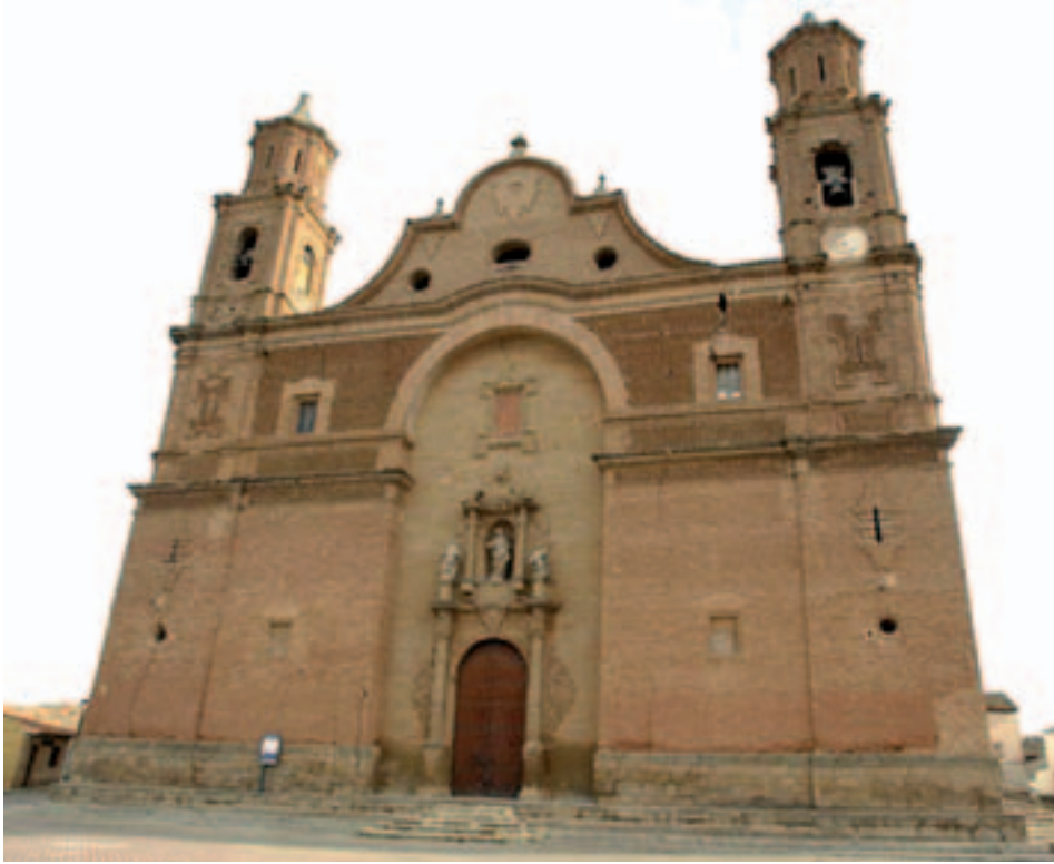
Fig. 7. Fachada principal de la Iglesia del Salvador de Samper de Calanda. Se aprecia el remate de perfil mixtilíneo, similar al que se pensaba realizar en la Iglesia de la Natividad de Nuestra Señora de La Puebla de Híjar hasta la modificación de Agustín Sanz.
