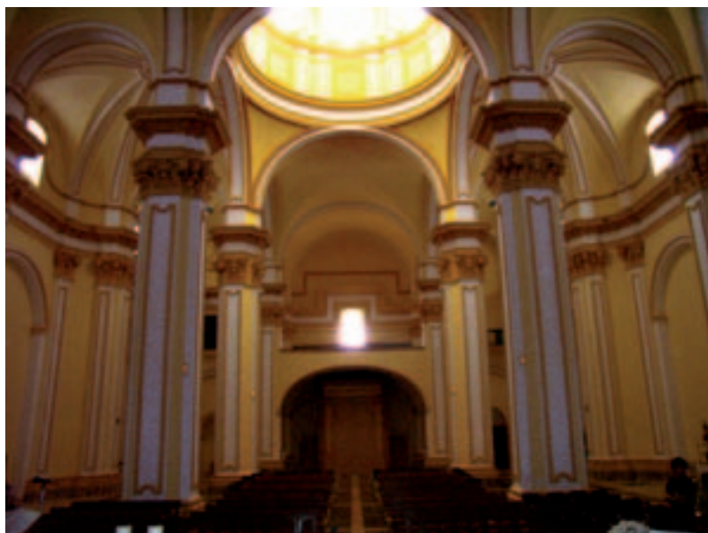
Fig. 11. Vista general del interior del Templo parroquial de La Natividad de Nuestra Señora hacia los pies. Se aprecia la sencilla solución dada a las pilastras y a los trozos de entablamento sobre los pilares.
