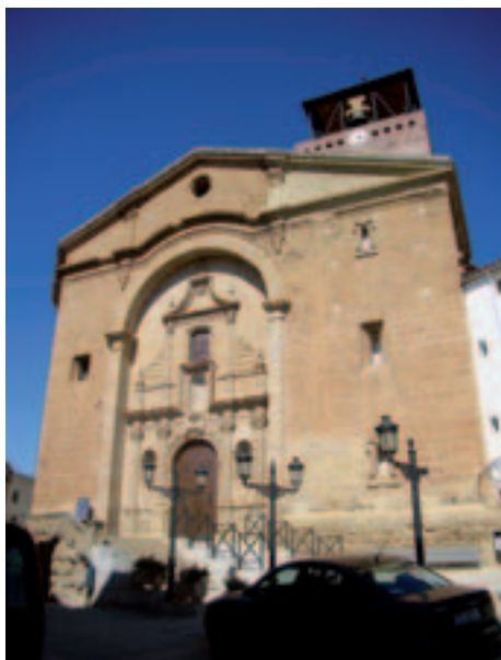
Fig. 8. Fachada principal de la Iglesia de La Natividad de Nuestra Señora de La Puebla de Híjar. Se aprecia el remate en frontón triangular fruto de la modificación de Agustín Sanz.
