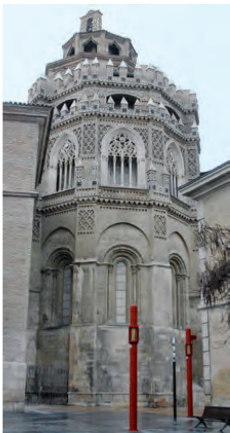
Fig. 12. Ábside central de la Seo de Zaragoza, con el cimborrio levantado en el siglo XVI.
