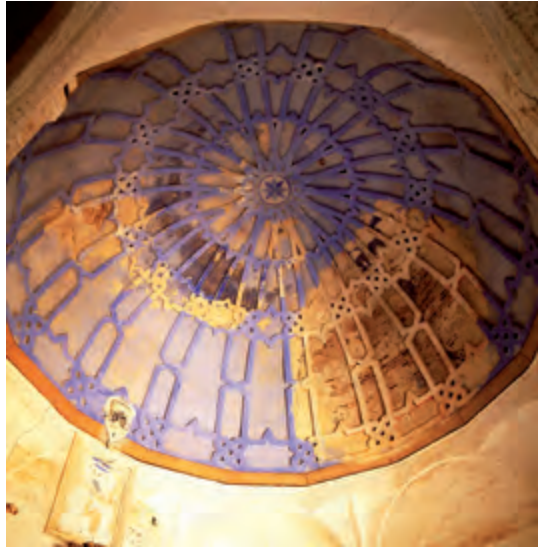
Fig. 4. Bóveda de la capilla de los Zuazo en el monasterio de La Mejorada de Olmedo (Foto: Santos Cid, publicada en Arte mudéjar en la provincia de Valladolid, Valladolid, Diputación de Valladolid, 2007, p. 173 ).
