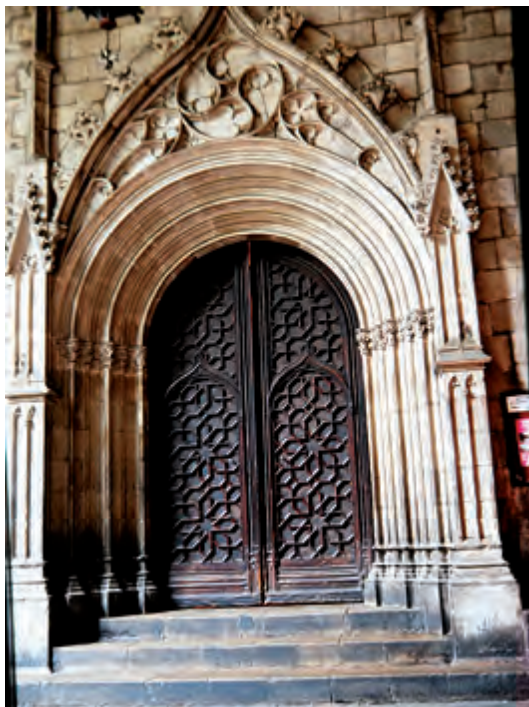
Fig. 8. Barcelona. Catedral. Puerta de la antigua Sala Capitular en el claustro. Foto: Rosa Terés.
