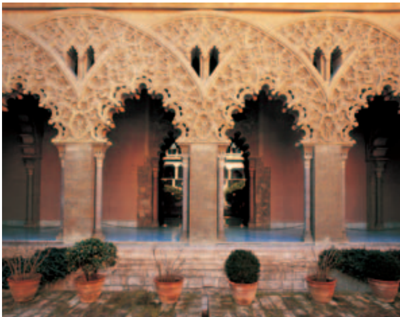
Fig. 4. Testero meridional del palacio de la Aljafería tras la reconstrucción de su pórtico. Fotografía de Ricardo Vila.
