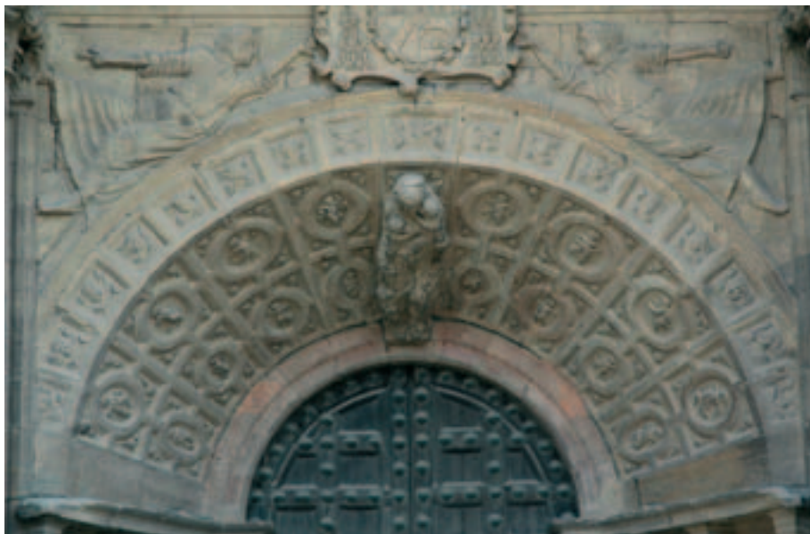
Fig. 26. Tarazona (Zaragoza). Catedral. Portada septentrional. Detalle de la trompa de ángulo obtuso del acceso. Foto: Javier Ibáñez.
