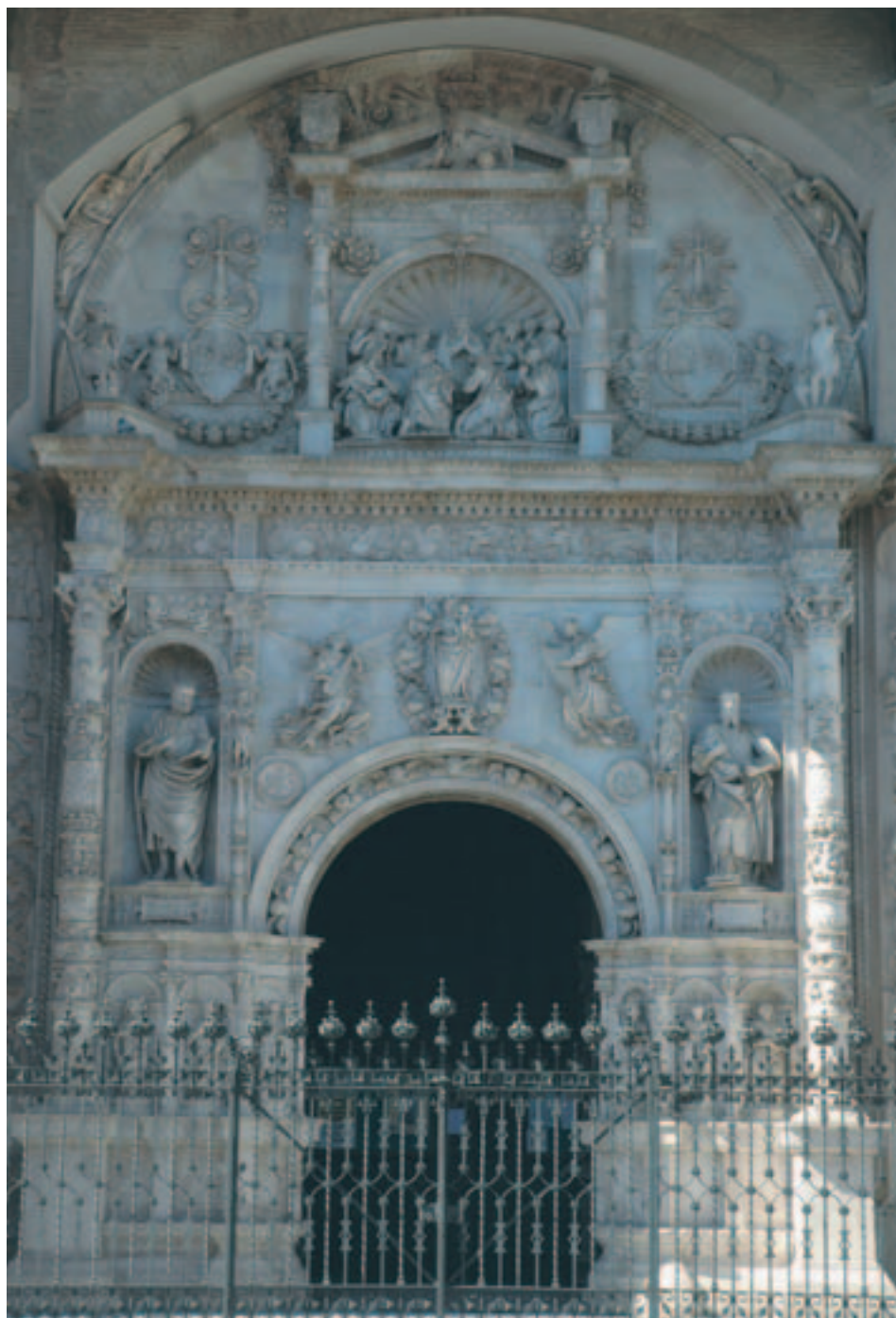
Fig. 5. Calatayud (Zaragoza). Iglesia de Santa María. Portada principal. Foto: Javier Ibáñez.
