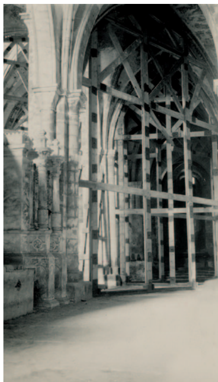
Fig. 3. Cabecera de la iglesia del monasterio de Rueda en septiembre de 1927 (fotografía Teodoro Ríos), Archivo CCHS (CSIC).
