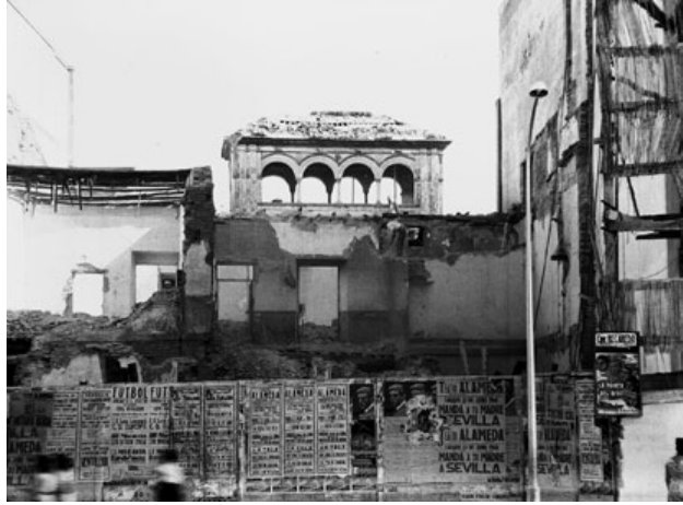
Fig. 9. Antonio Palau. Derribo. Calle Almirante Valdés nº5. Sevilla. 5/6/1960. Celuloide. 13x18.
