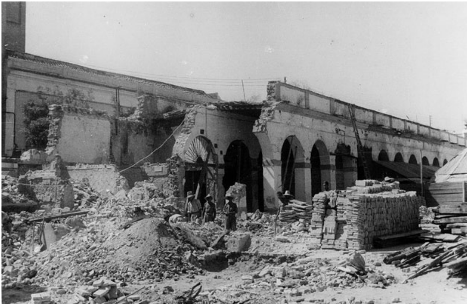
Fig. 10. Derribo del mercado de la Encarnación. Sevilla.
