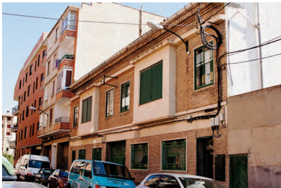
Fig. 6. Fábrica de chocolate. Zaragoza. Antigua fábrica de chocolates Zorraquino. Alzado principal. Foto: Carlos Colás.
