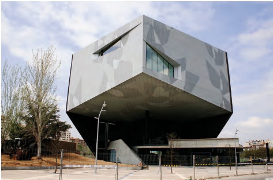
Fig. 15. CaixaForum, vista desde la avenida de Anselmo Clavé.
