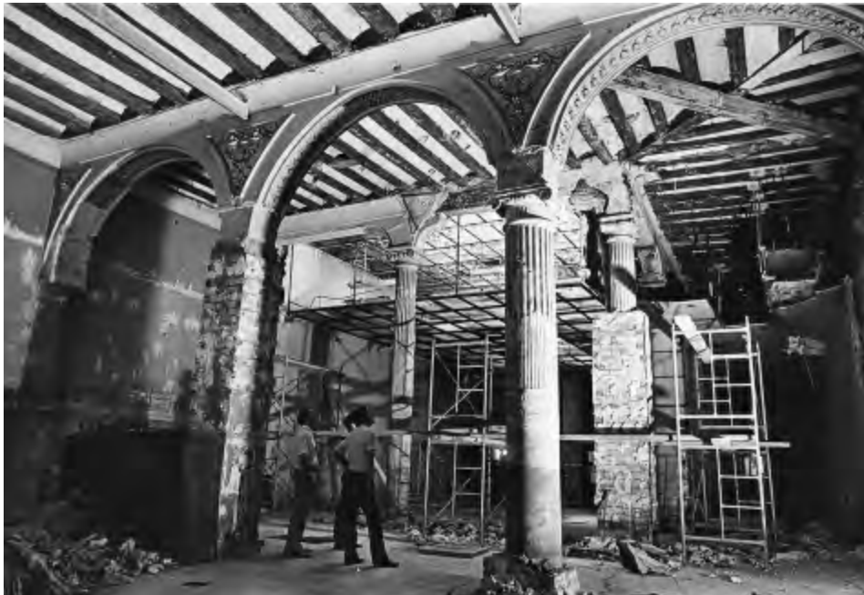
Fig. 6. Interior del patio del Palacio de Sástago durante su restauración (Fotografía procedente de los fondos de la DPZ).
