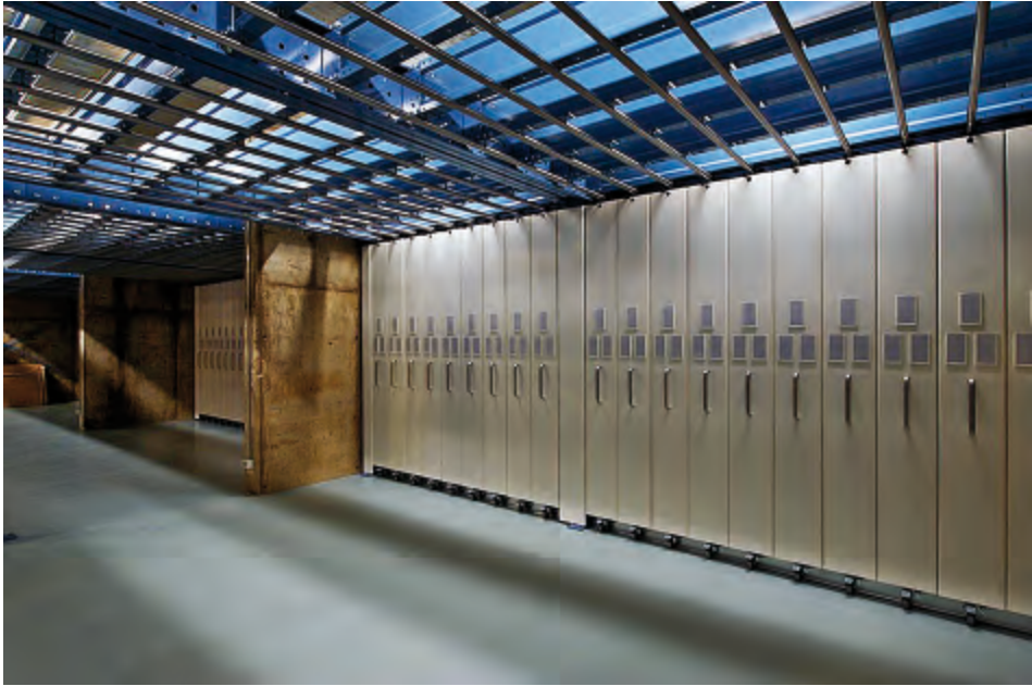
Fig. 6. Áreas de reserva. Almacén de pintura.
