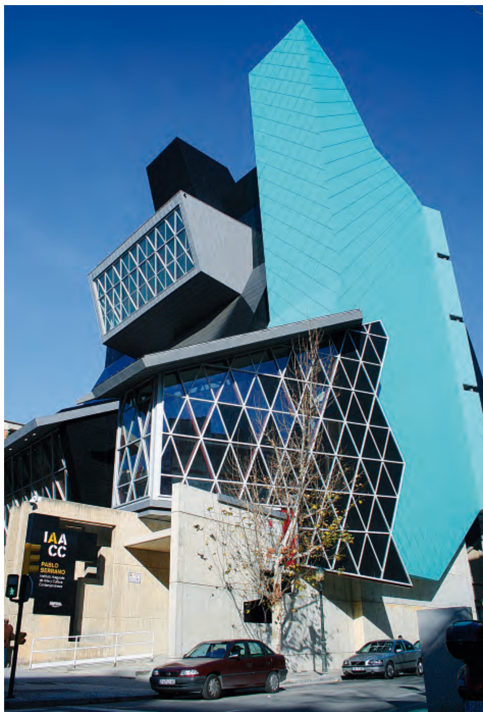
Fig. 3. Fachada lateral y acceso.
