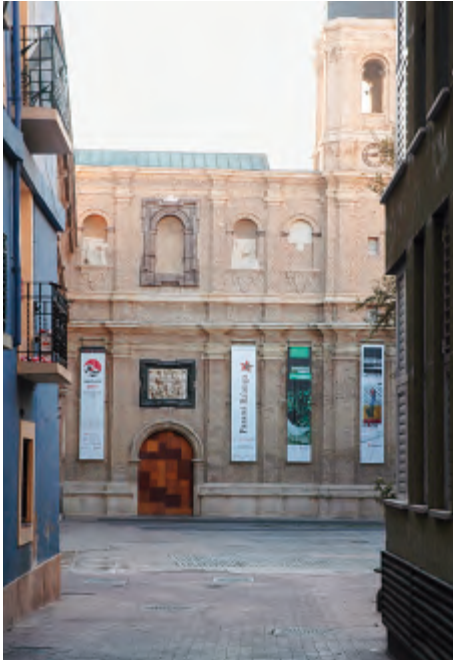
Fig. 1. Plaza de San Agustín. Entrada principal. Fachada de la antigua iglesia.
