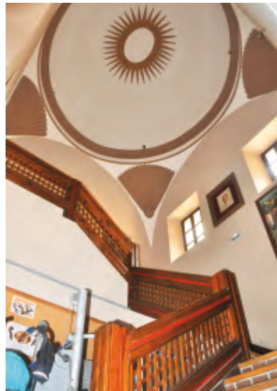
Fig. 10. Escalera del antiguo colegio de la Compañía de Jesús de Tudela. Foto: M a J. Tarifa Castilla.
