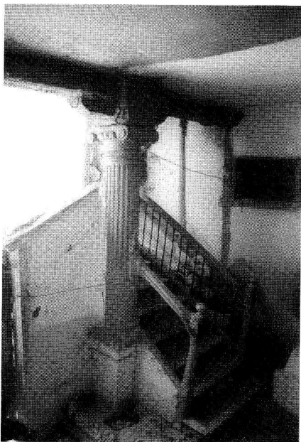
Fig. 9. San Blas 12. Columna y su plinto en la planta baja, apoyo de la estructura de pilares y vigas de madera de los pisos superiores.
