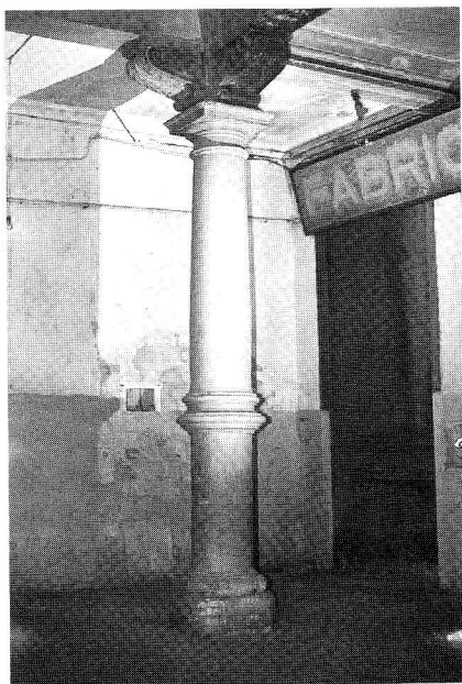
Fig. 13. Casa llamada de los Estébanes. Columna toscana anillada de la planta baja de la luna. Hoy, pasaje de los Giles.
