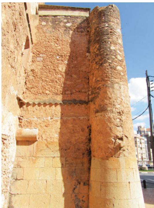
Fig. 8. Vista de los restos de uno de los baluartes del Palacio de Betxí, Fotografía Milena Villalba.
