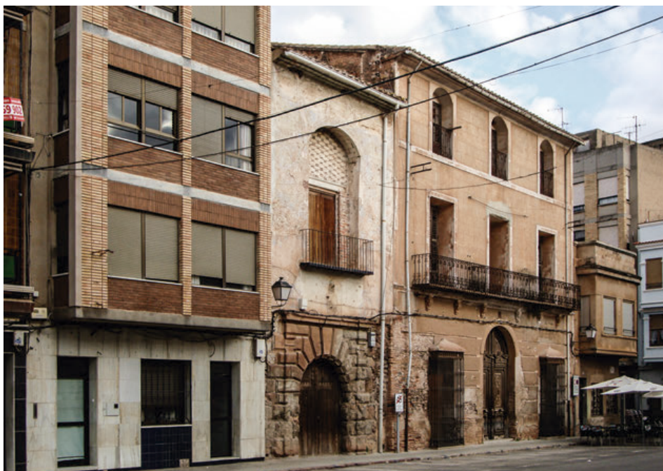
Fig. 1. Fachada del palacio de Betxí, antes de comenzar los trabajos de restauración. Fotografía: Milena Villalba.
