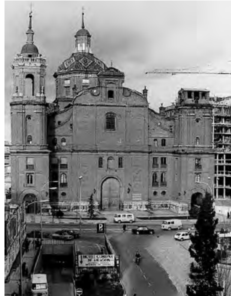
Fig. 11. Iglesia de San Ildefonso desde la Plaza de Salamero. Gerardo Sancho (26-I-1977). A.M.Z. Se aprecia la diferencia de color entre los ladrillos del edificio barroco y el nuevo remate, más claros.
