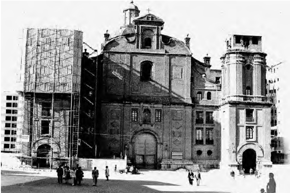
Fig. 7. Vista de la fachada de la iglesia de San Ildefonso durante los trabajos de construcción del remate de la torre del lado de la Evangelio. Gerardo Sancho (15-XI-1972). A.M.Z.
