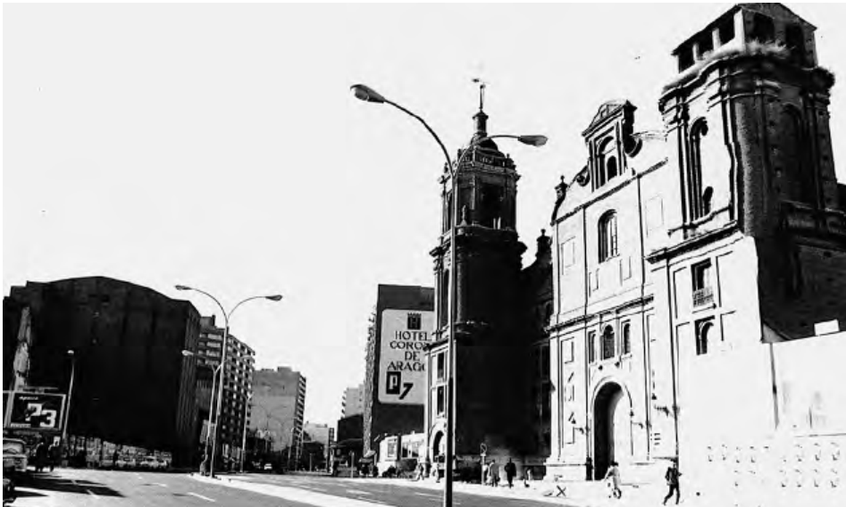
Fig. 10. Panorámica de la Vía Imperial en el tramo correspondiente a la iglesia de San Ildefonso. Gerardo Sancho (31-X-1974). A.M.Z.
