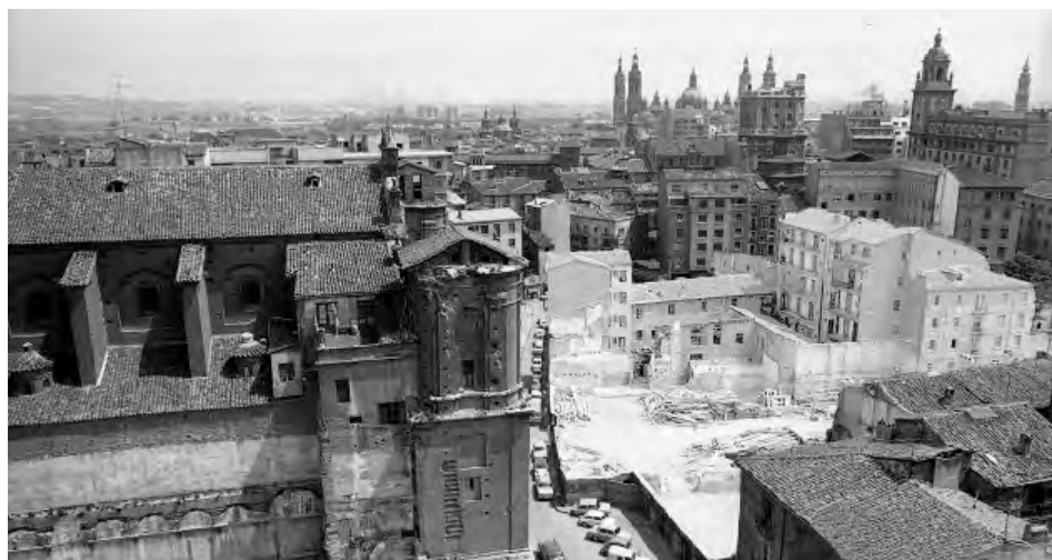
Fig. 3. Vista aérea de la evolución de los trabajos de apertura de la Vía Imperial, Gerardo Sancho (20-VII-1970). A.M.Z. En color más claro se han marcado los solares y construcciones que formaban la manzana que se levantaba delante de la iglesia de San Ildefonso, a la izquierda de la imagen. Puede verse incluso el antiguo trazado de la calle del mismo nombre.
