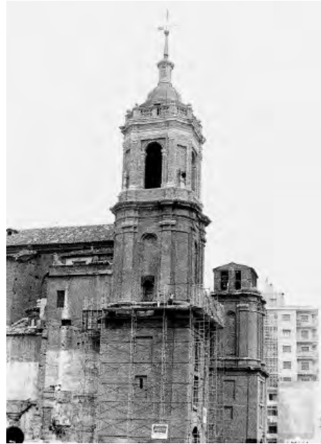
Fig. 9. Desmontaje de los andamios tras la finalización de la construcción del remate de la torre del cuerpo del Evangelio. Gerardo Sancho (17-IX-1973). A.M.Z.
