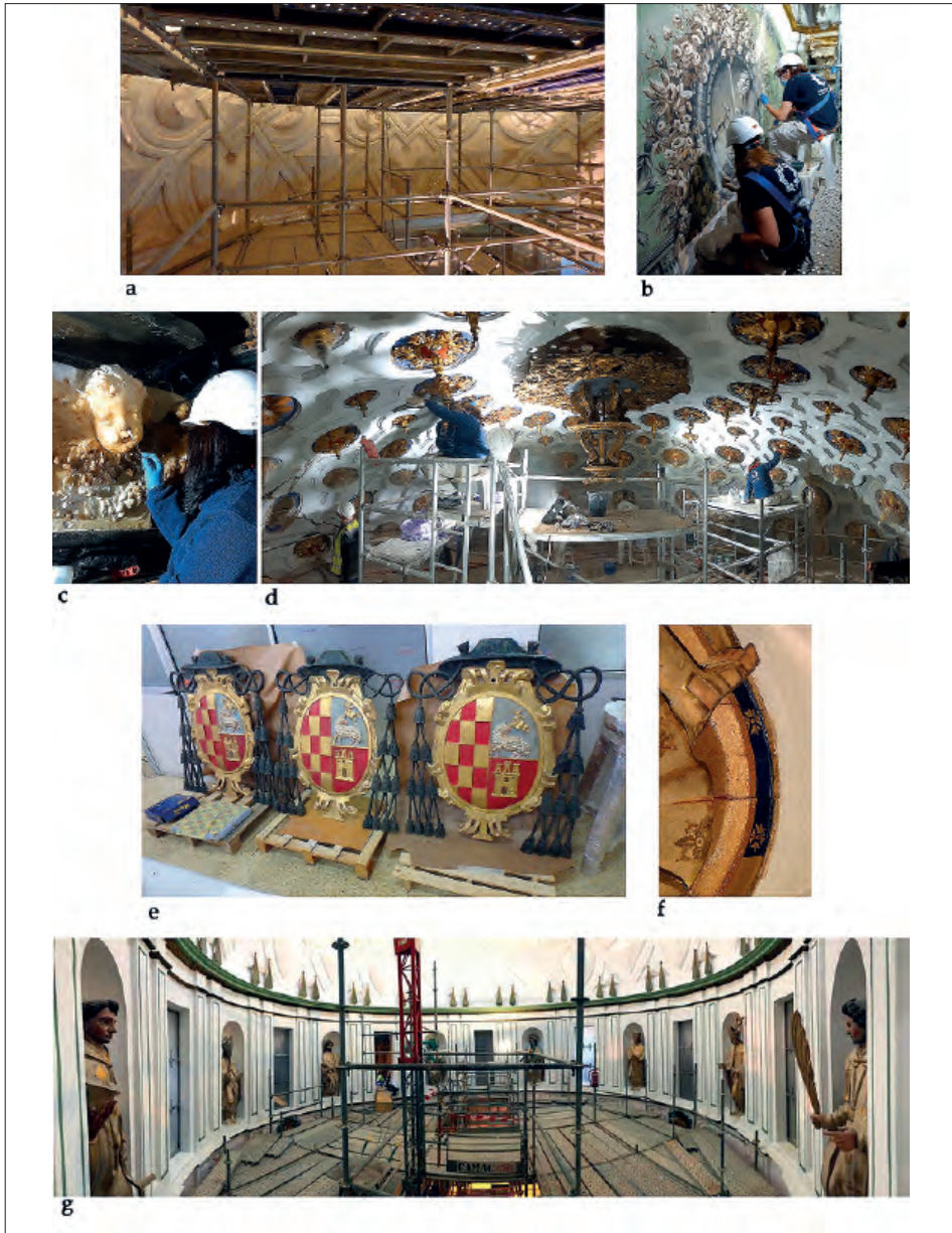
Fig. 5. Restauración de los sistemas decorativos: a) Yesos cortados en la cúpula, durante las obras de 2018; b) Pintura mural en la portada de la capilla de San José, en 2022; c) Limpieza de los relieves de alabastro en la portada de la capilla de San Juan Bautista en 2021; d) Pinjantes de madera dorada y policromada de la capilla mayor, en 2022; e) Escudos de armas pertenecientes al tambor de la cúpula, durante su restauración en taller, en 2018; f) Detalle de la recuperación de la policromía original de los tondos de los evangelistas, en 2018; g) Panorámica de la decoración escultórica del tambor de la cúpula, durante la intervención de 2018.
