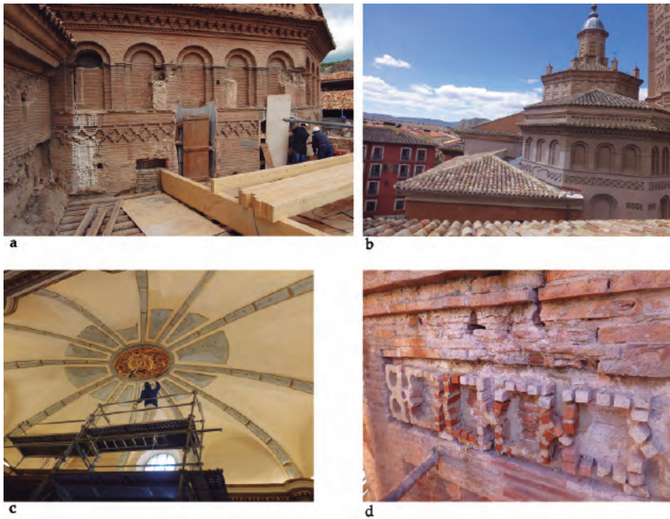
Fig. 7. Obras de restauración del ábside y la sacristía en 2015: a) Estructuras del siglo XVI y XVII en el ábside, durante la sustitución de la cubierta del cuerpo de la sacristía; b) Resultado final, con liberación de la galería y disposición de lucernarios para iluminar la capilla mayor; c) Restauración de la decoración pictórica de la bóveda de la sacristía; d) Restauración de las labores de ladrillo en el ábside medieval.
