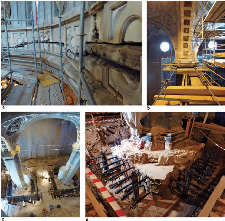
Fig. 4. Actuaciones para consolidación estructural del crucero en 2013: a) Aspecto de la grieta horizontal situada en la base del tambor, y del encadenado de madera oculto, en el comienzo de las obras; b) Sustitución del sistema de atirantado en los arcos torales; c, d) Proceso de refuerzo y apantallado de las zapatas.
