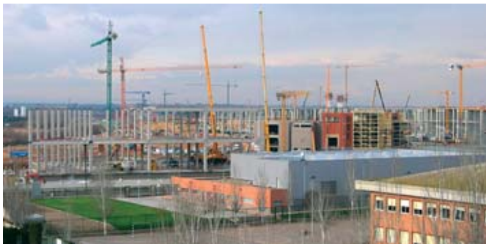
Fig. 16. Vista general de las obras. Fotografía: Isabel Yeste Navarro.
