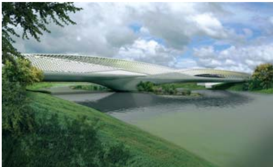
Fig. 3. Pabellón Puente, vista general (Zaha Hadid Architects y Arup).
