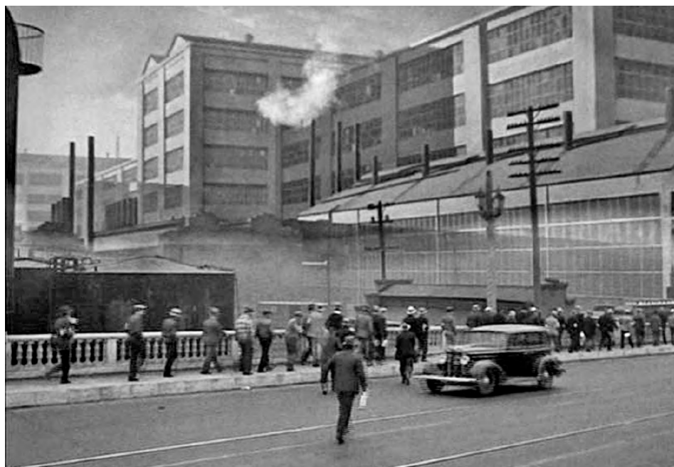
Fig. 11. Tiempos Modernos. Vista exterior de la fábrica.
