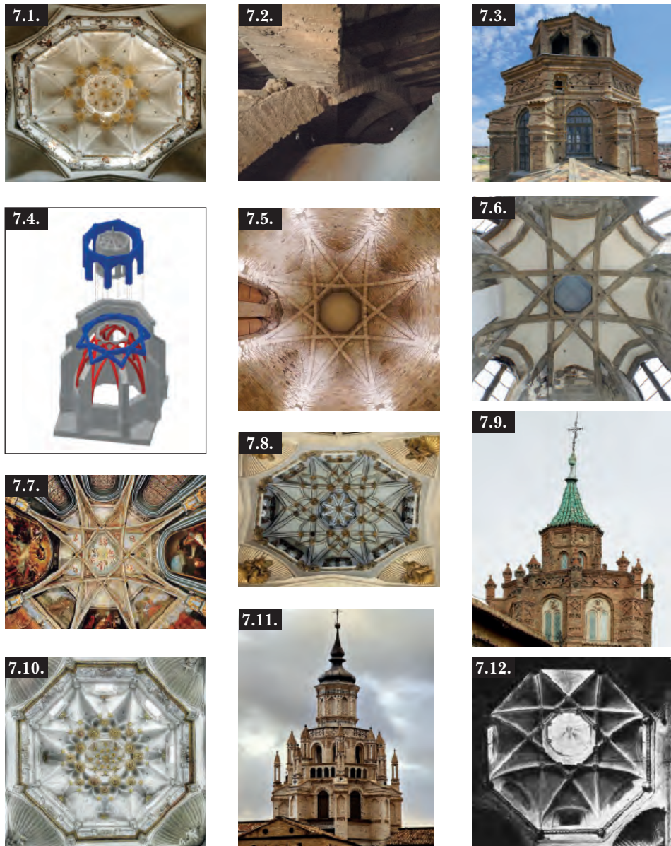
Fig. 7. 7.1. Zaragoza. Catedral. Cimborrio. Bóveda del tambor; 7.2. Zaragoza. Catedral. Cimborrio. Detalle de la segunda red de arcos entrecruzados; 7.3. Zaragoza. Catedral. Cimborrio. Exterior; 7.4. Esquema estructural del cimborrio de la catedral de Zaragoza (Francisco Fes); 7.5. Durham. Catedral. Cocina. Detalle del sistema de abovedamiento; 7.6. Viena. Catedral. Torre sur. Detalle del sistema de abovedamiento; 7.7. Bayeux. Palacio episcopal. Capilla. Detalle del sistema de abovedamiento; 7.8 y 7.9. Teruel. Cimborrio. Interior y exterior; 7.10 y 7.11. Tarazona (Zaragoza). Catedral. Cimborrio. Interior y exterior; 7.12. Teruel. Casa de los Segura (desaparecida). Detalle del sistema de cubierta de la caja de escaleras.
