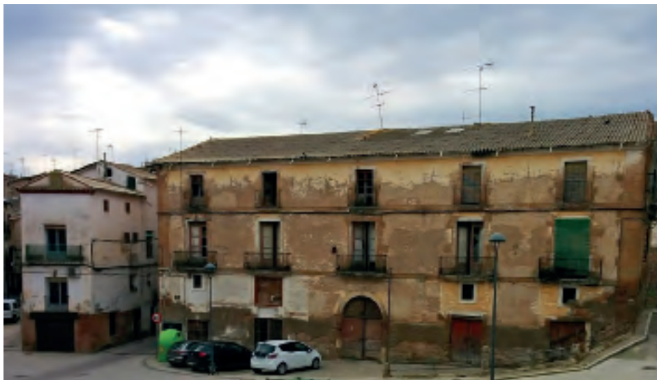
Fig. 4. Fachada principal (plaza del Mesón) de Casa Berdié, en 2018. Fotografía: CELLIT.
