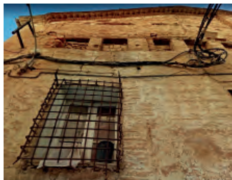
Fig. 5. Fachada lateral (calle Caballeros) de Casa Berdié, detalle.
