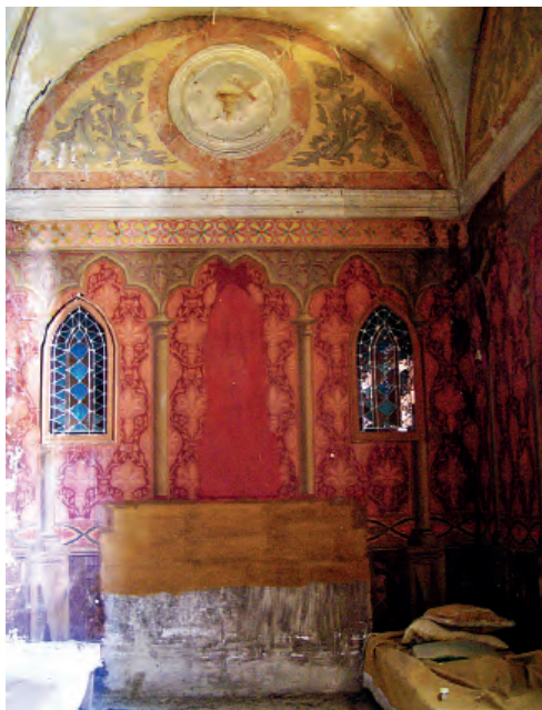
Fig. 7. Capilla de Casa Berdié, decoración neogótica de finales del siglo XIX. Fotografía: CELLIT.
