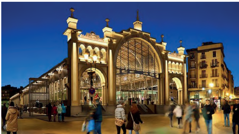
Fig. 6. Infografía de exterior del Mercado Central de Zaragoza, reinaugurado el 6 de febrero de 2020, con la nueva iluminación de led.
