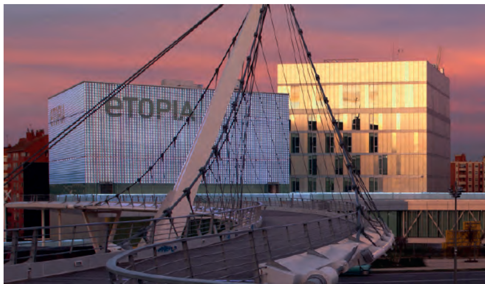
Fig. 1. Vista exterior del Centro de Arte y Tecnología Etopía.
