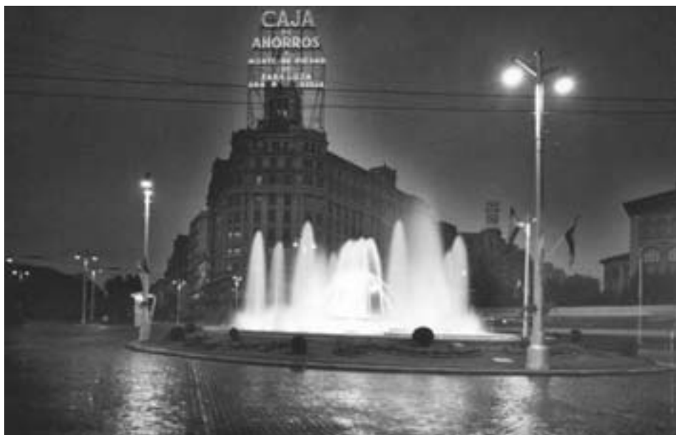
Fig. 10. Vista de la fachada que abría hacia la plaza de Basilio Paraíso en 1960, con del rótulo luminoso de la Caja de Ahorros y Monte de Piedad (desaparecido).
