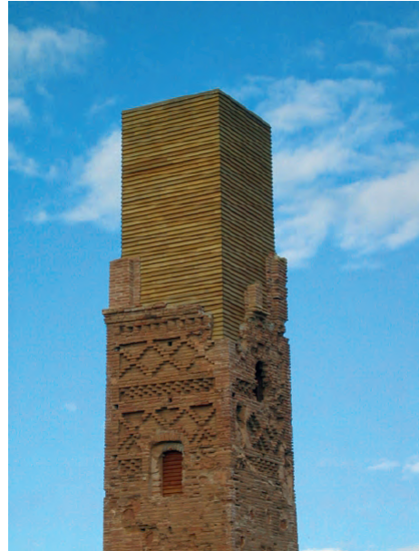
Fig. 2. Coronación de la Torre del Reloj tras la intervención. Fotografía: J. Borobio Sanchiz, archivo BAU, exp. n.º 200211.
