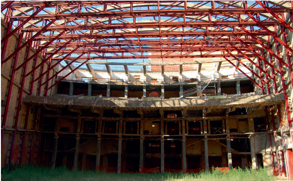
Fig. 1. Estado actual del Teatro Cine Fleta.
