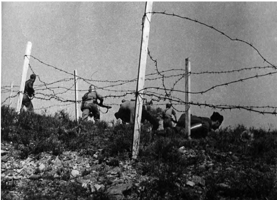
Fig. 5. Alambrada en el frente de Aragón, finales de septiembre de 1937. Agustí Centelles i Ossó.
