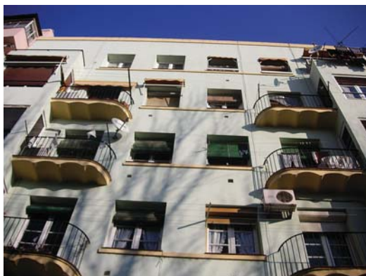
Fig. 6. Fachada posterior de la calle de Conde Aranda, 79.
