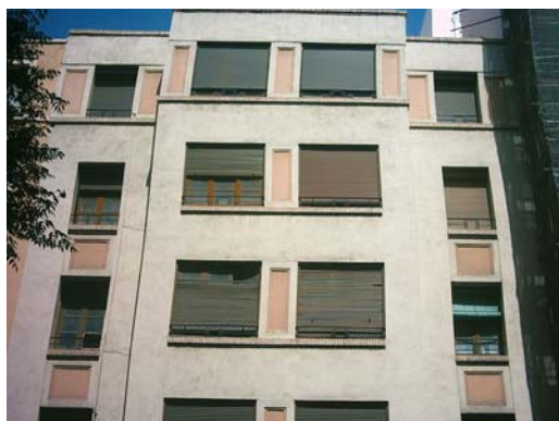
Fig. 19. Fachada de la calle de Hernán Cortés, 16.
