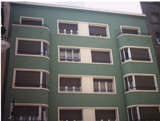
Fig. 3. Fachada de la calle de Conde Aranda, 79.
