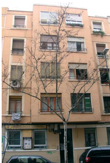
Fig. 18. Fachada de la calle Hernán Cortés, 18.
