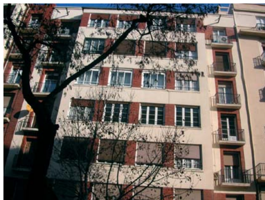
Fig. 8. Fachada de la calle de San Clemente, 21.
