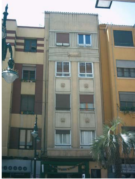
Fig. 10. Fachada de la calle de Conde Aranda, 35.
