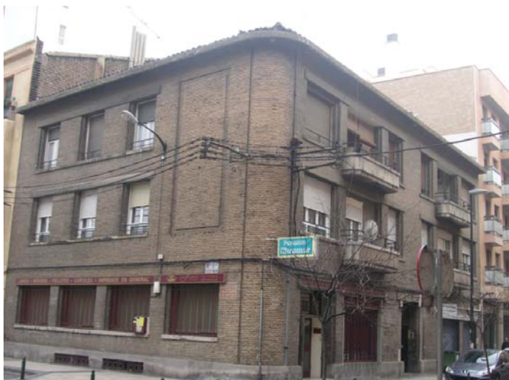
Fig. 24. Fachada de la calle de Madre Sacramento, 46.
