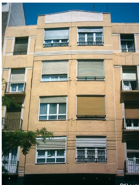
Fig. 15. Fachada de la calle Hernán Cortés, 20.
