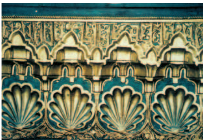
Fig. 6. Detalle del registro inferior de la techumbre de limas moamares de la capilla de San Miguel Arcángel de la Seo de El Salvador de Zaragoza donde en los lados suroeste, noreste y noroeste se dispusieron en el interior de arcos de mocárabes conchas o veneras.
